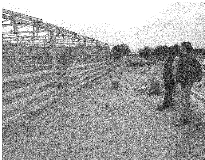
Foto N°4: Proyecto IFP Oriel Valenzuela, Construcción de corral.
