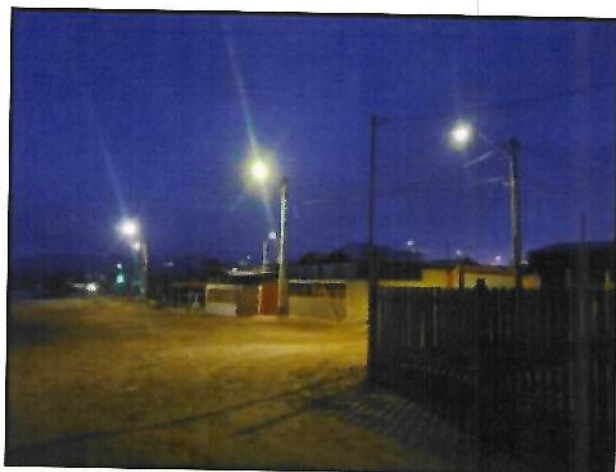
Renovación Alumbrado Público Carrizal Bajo
