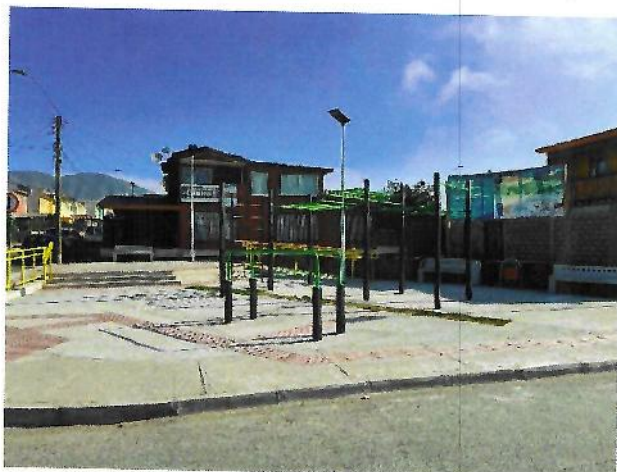
Construcción Plaza Arauco
